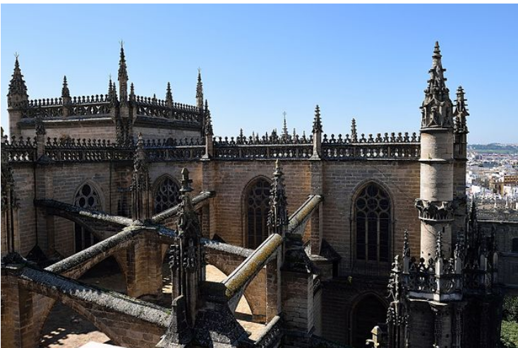
Cubiertas de la Catedral de Sevilla
